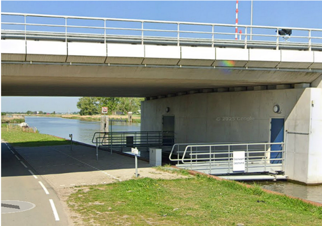
Afbeelding 3. Kogerpolderbrug (Noord-Holland) waar mogelijk een laadpunt gerealiseerd wordt. Bron: Google Streetview
